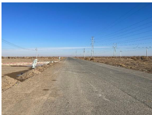
项目东侧园区道路
