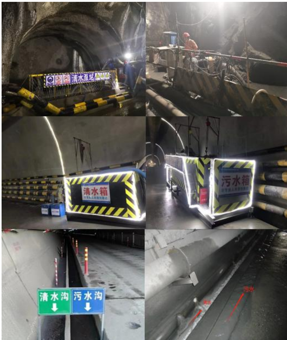
图 7.3.2-9 隧洞清污分流设施实例图
