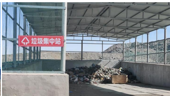
现有生活垃圾收集池
