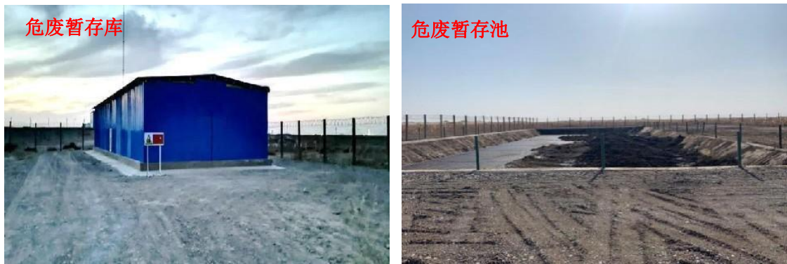
图 3.1-3 危废暂存池、危废暂存库现场照片
