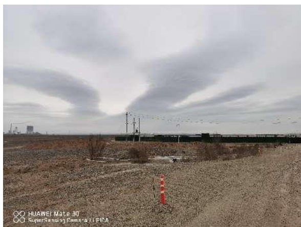
项目区东南侧园区变电站
