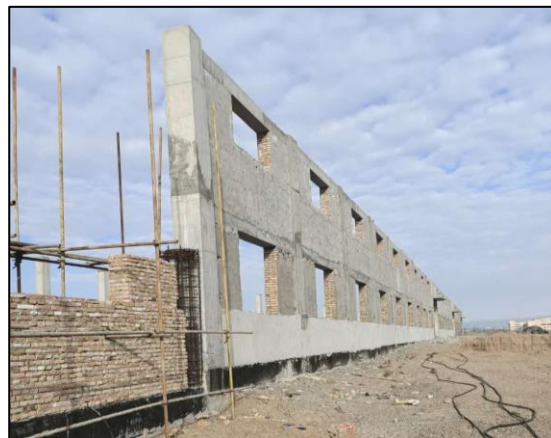
新建提金车间建设情况 (b)
