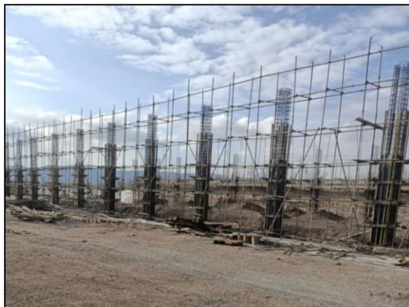
新建提金车间建设情况 (a)
