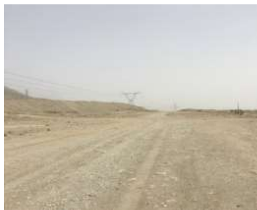
已经施工的便道工程
