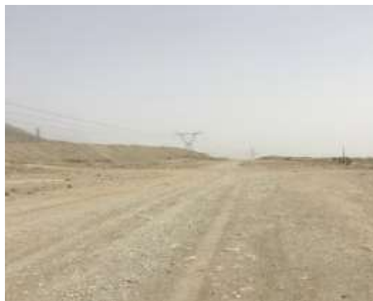
已经施工的便道工程
