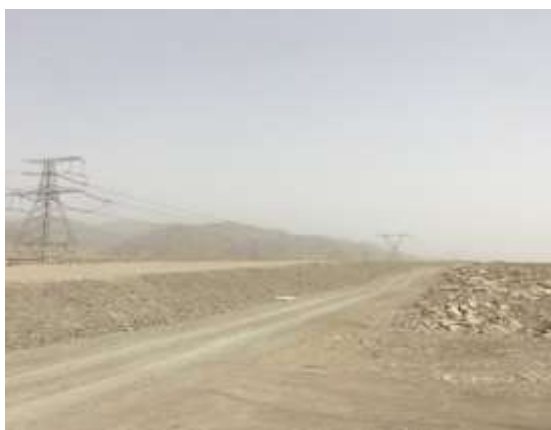
已施工的路基工程
