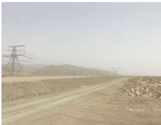
已施工的路基工程
