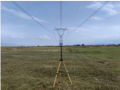
750kV 伊库 I 回监测现场照片
