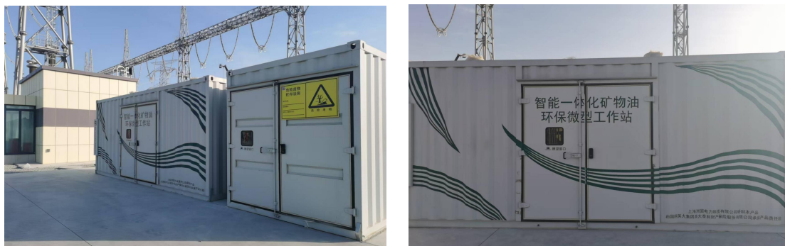
图 6.4-1 若羌 750 千伏变电站站内危险废物贮存库现状
