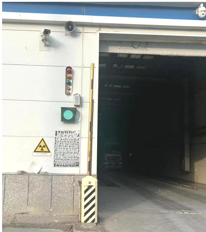
图 10-6 检查系统出束警灯和警铃示意图
