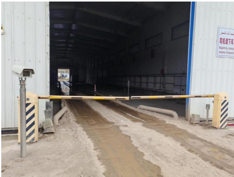
图 10-8 检查系统红外报警装置和挡杆示意图
