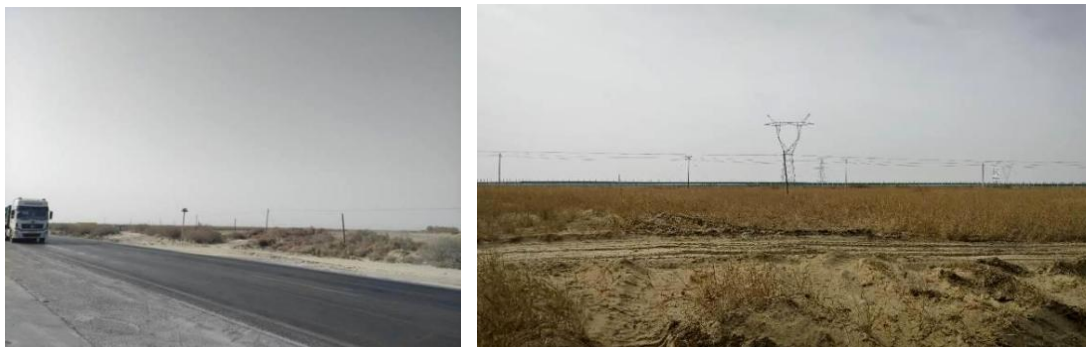
图 3.1-11 跨越高速公路及国道
