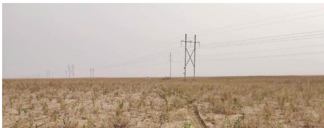
图 3.1-10 跨越 110 千伏民安线和 35 千伏安柳线
