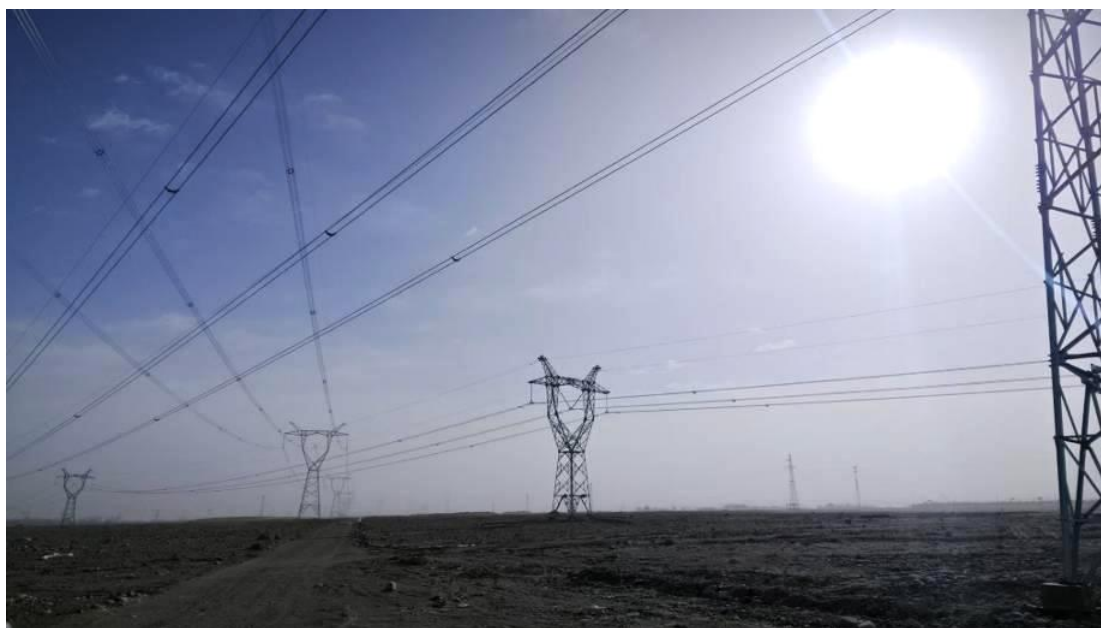
图 3.1-7 跨越尼雅-民丰 220 千伏 I、II 线
