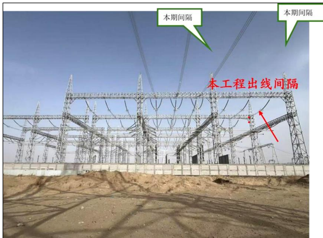
图 3.1-5 且末 750kV 变电站站址现状
