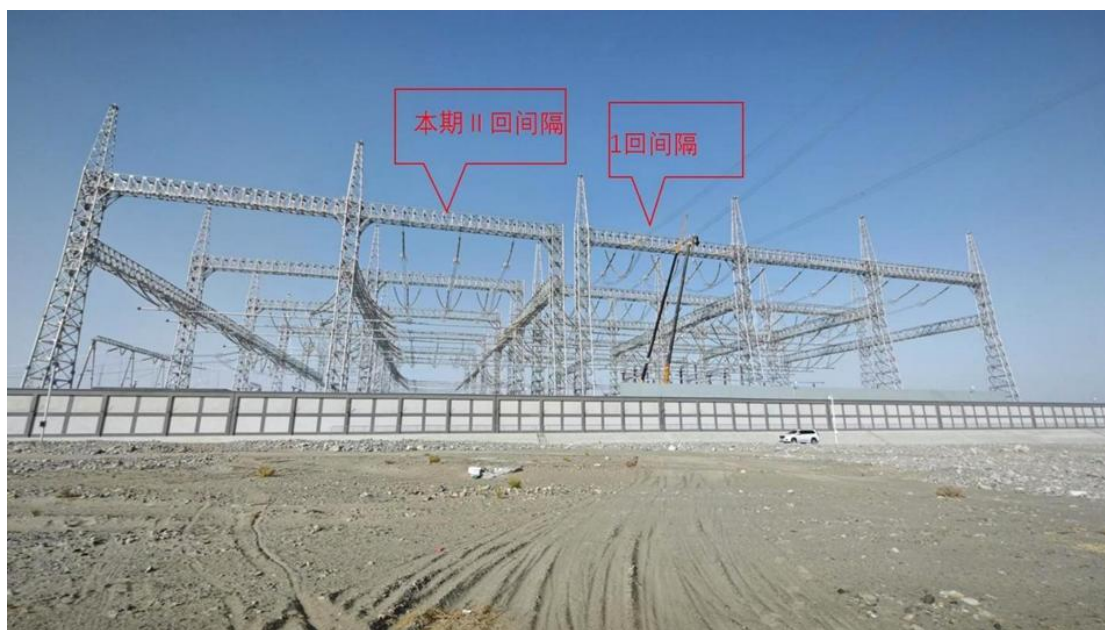
图 3.1-2 民丰 750kV 变电站站址现状
