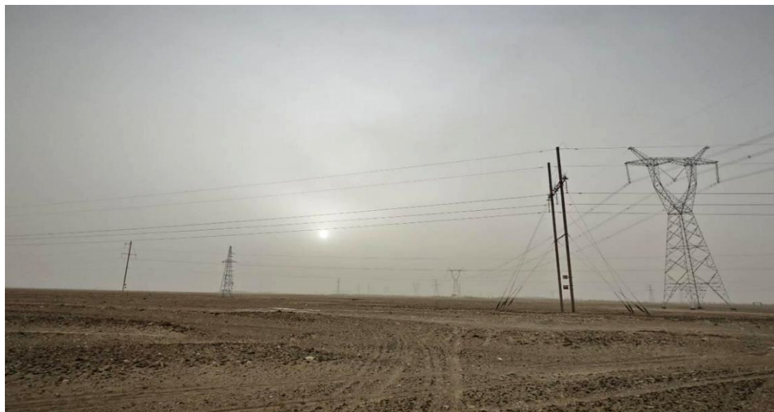
图 3.1-8 跨越和田-民丰 110 千伏 I、II 线和 35 千伏线
