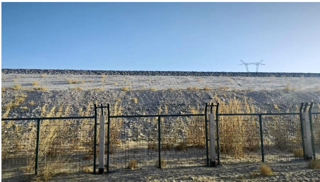
图 3.1-12 跨越和若铁路
