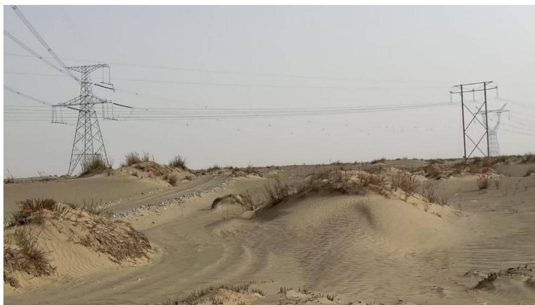
图 3.1-9 跨越 220kV 塔且线
