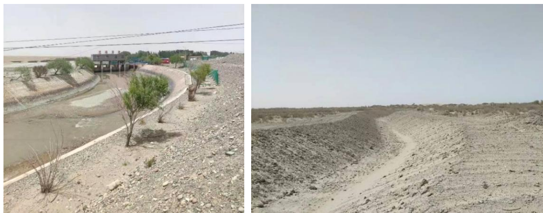
图 3.1-13 线路沿线跨越河流
