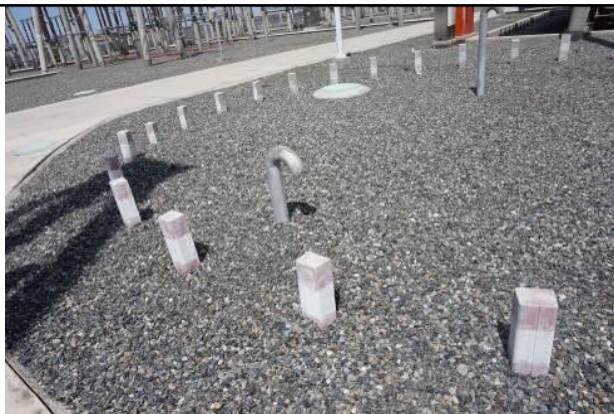
图 2-2 崇光变事故油池
