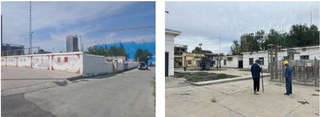
图 3-1 中心 110 千伏变电站周围环境
