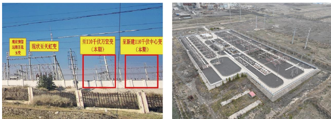
图 3-2 崇光 220 千伏变电站区域周围环境
