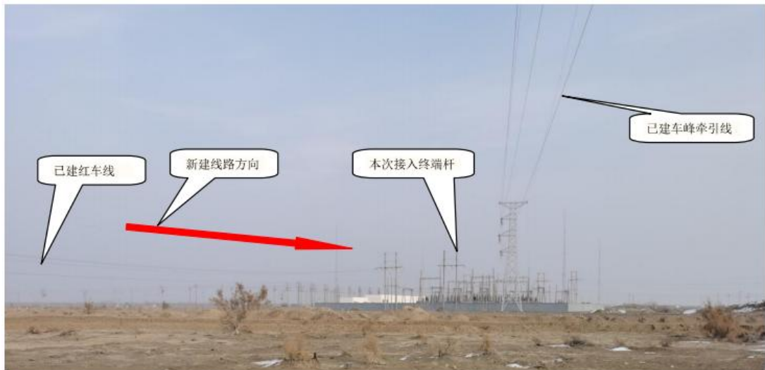
图 2-18 110kV 车排子变出线侧现状
