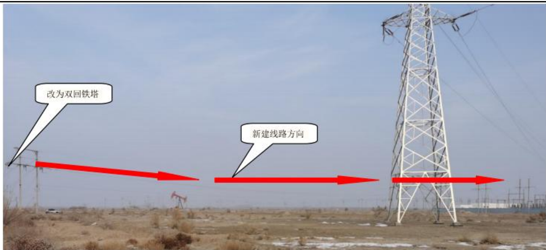
图 2-19 110kV 车排子变出线侧现状
