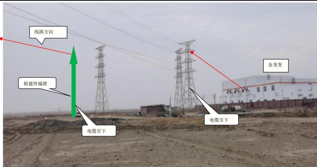
图 2-16 110kV 金龙变出线侧现状
