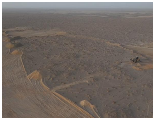
伊州 750kV 变电站出线侧现状照片
