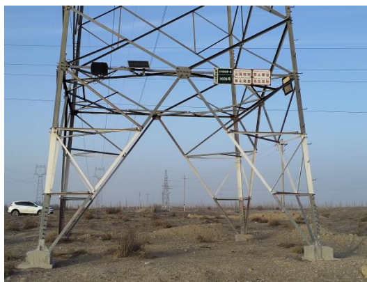
220kV 银南牵一线 26#塔现状照片
