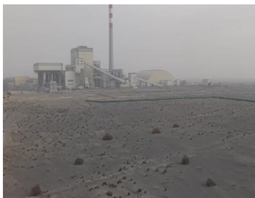
国能电厂侧出线侧现状照片
