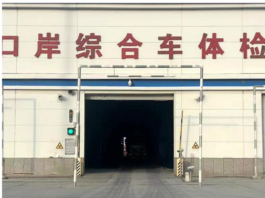
图 10-7 检查系统红外报警装置和挡杆示意图
