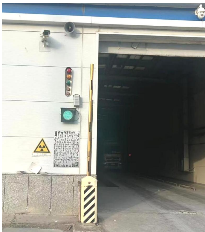
图 10-6 检查系统出束警灯和警铃示意图
