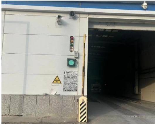
检查系统出束警示灯、警铃示意图和摄像头
