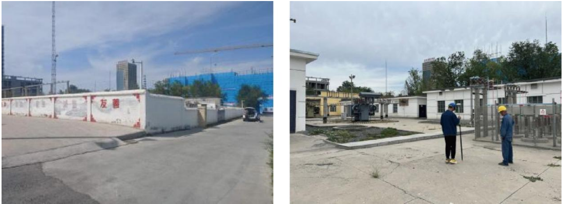
图 3-1 中心 110 千伏变电站周围环境
