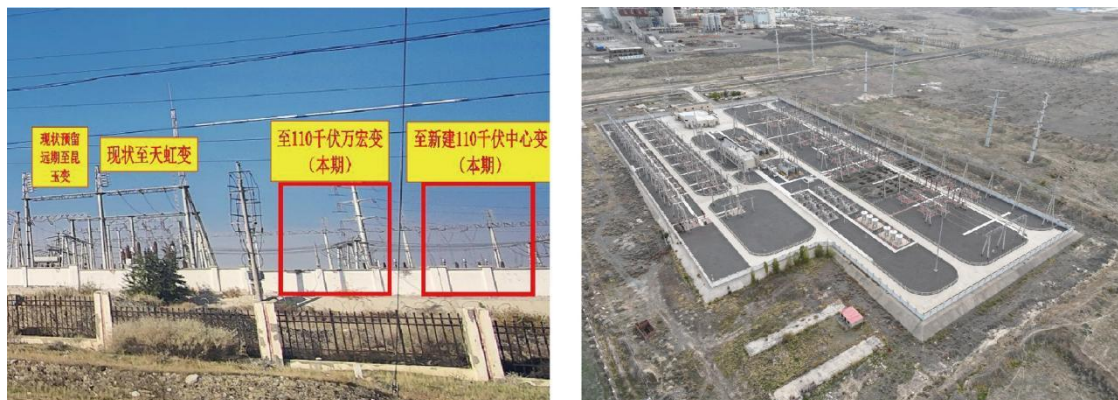
图 3-2 崇光 220 千伏变电站区域周围环境
