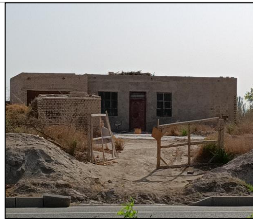
平房 4（废弃房屋）
