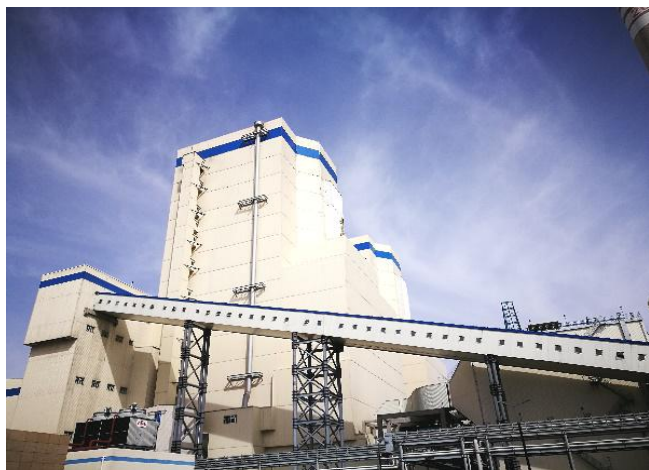
封闭输煤栈桥
