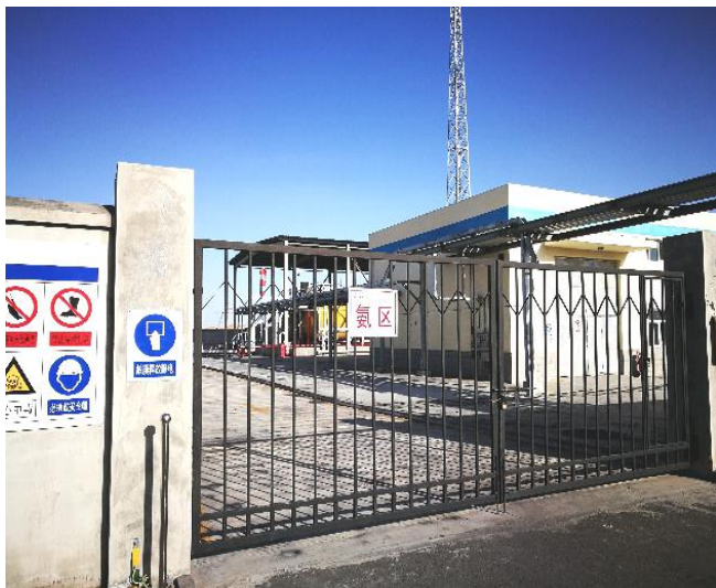
脱硝液氨罐区
