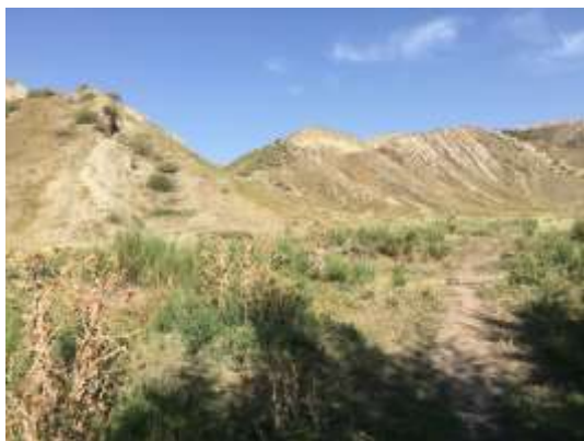
施工迹地恢复 (1)
