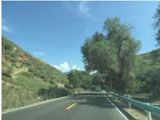
公路两侧迹地恢复
