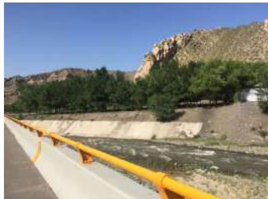
混凝土护坡
