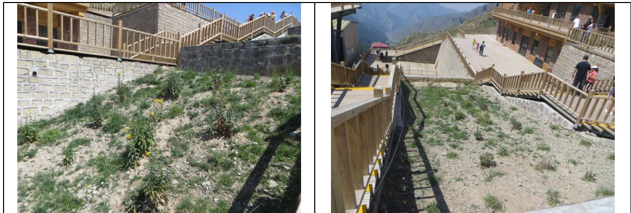
(2) 下站步行台侧植被恢复情况
