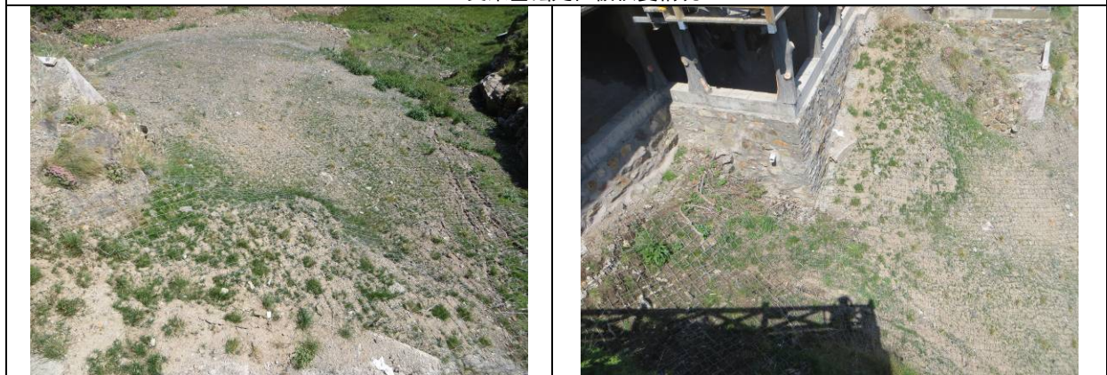
(4) 上站金属网护坡植被恢复情况
