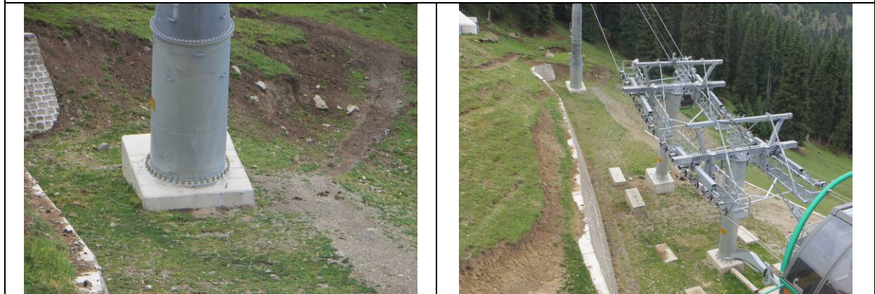
(3) 支架基础处植被恢复情况
