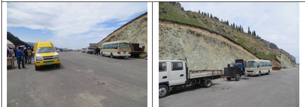
(1) 停车场地面硬化情况
