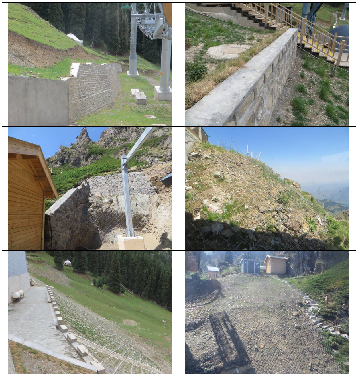
图 7.3-1 项目区水土保持措施落实情况
