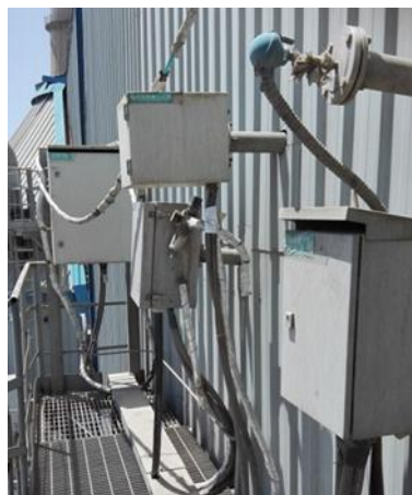
脱硫在线监测探头
