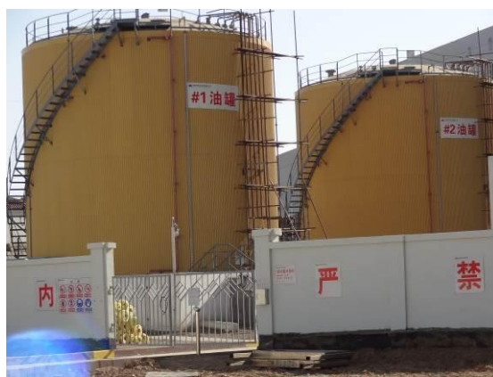
油罐区防渗、围堰
