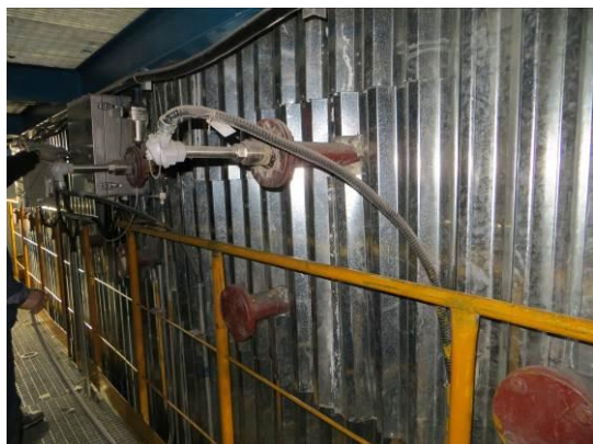
脱硝设施出口监测点位
