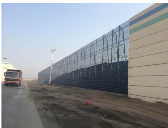
煤场防风抑尘网
