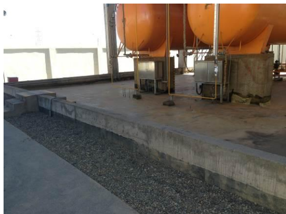
氨罐区防渗、围堰
