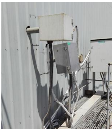
脱硫在线监测探头
