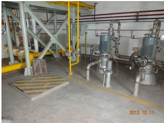
氨区事故水池
