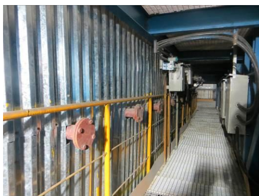
脱硝设施进口监测点位
