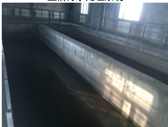
煤水处理车间
