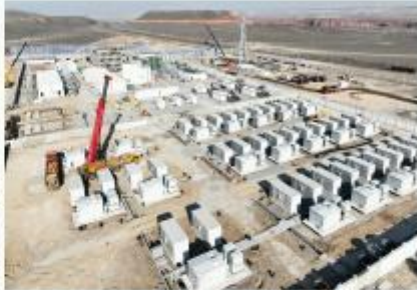
风电项目建设现场(吐番)。吐鲁番市融媒体中心记者 李博 摄
