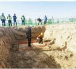
施工现场(吐番)。吐鲁番市融媒体中心记者 李博 摄
