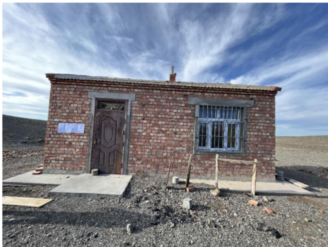
图 3.2-4 K30+700 牧民房屋现场张贴公告照片
