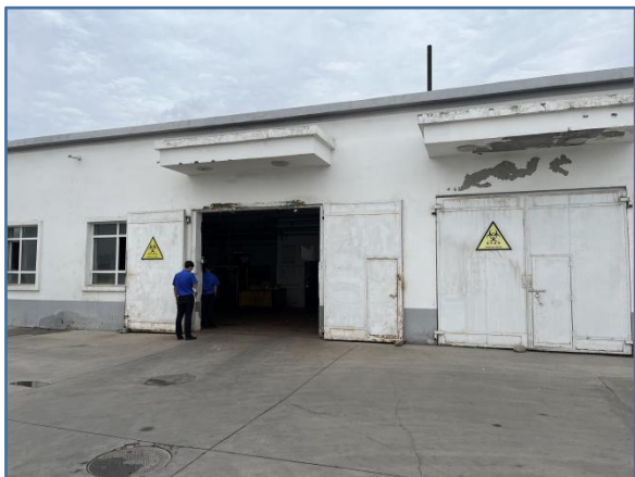
医疗废物处理车间
