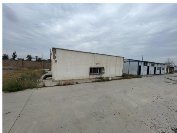
渗滤液收集池
