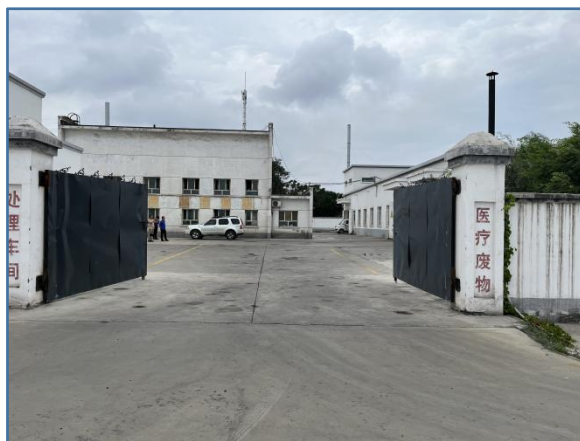
医疗废物处理车间
