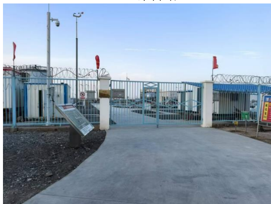
YQ5 混输泵站
