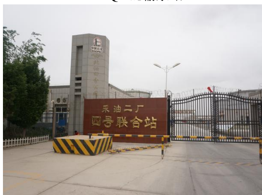
塔河油田四号联合站
