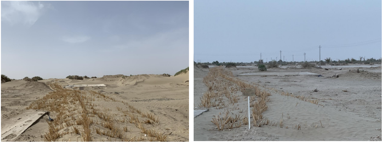
图 3.1-2 管道临时占地恢复情况
