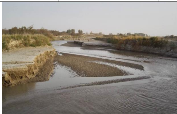
安迪尔引水渠首实景
