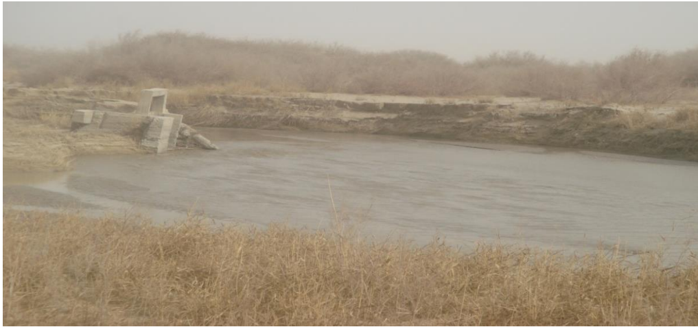
图 4.2-3 现状安迪尔渠首引水枢纽
