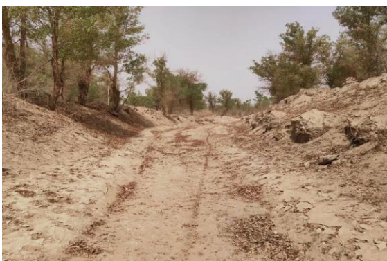
引水渠道沿线区
