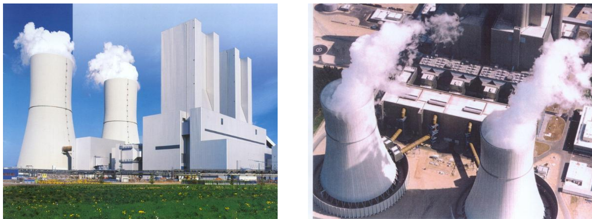
图 5.2-3 冷却塔排烟电厂外观
