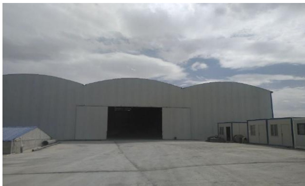
图 6.4.1-1 拌合站砂石料厂封闭
