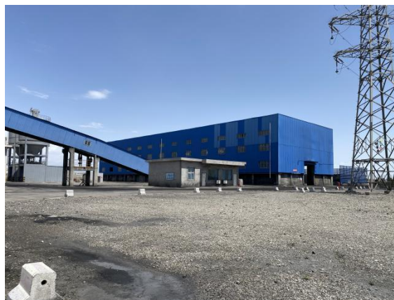
全封闭输煤通廊
