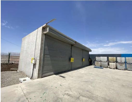
危废、固废暂存间
