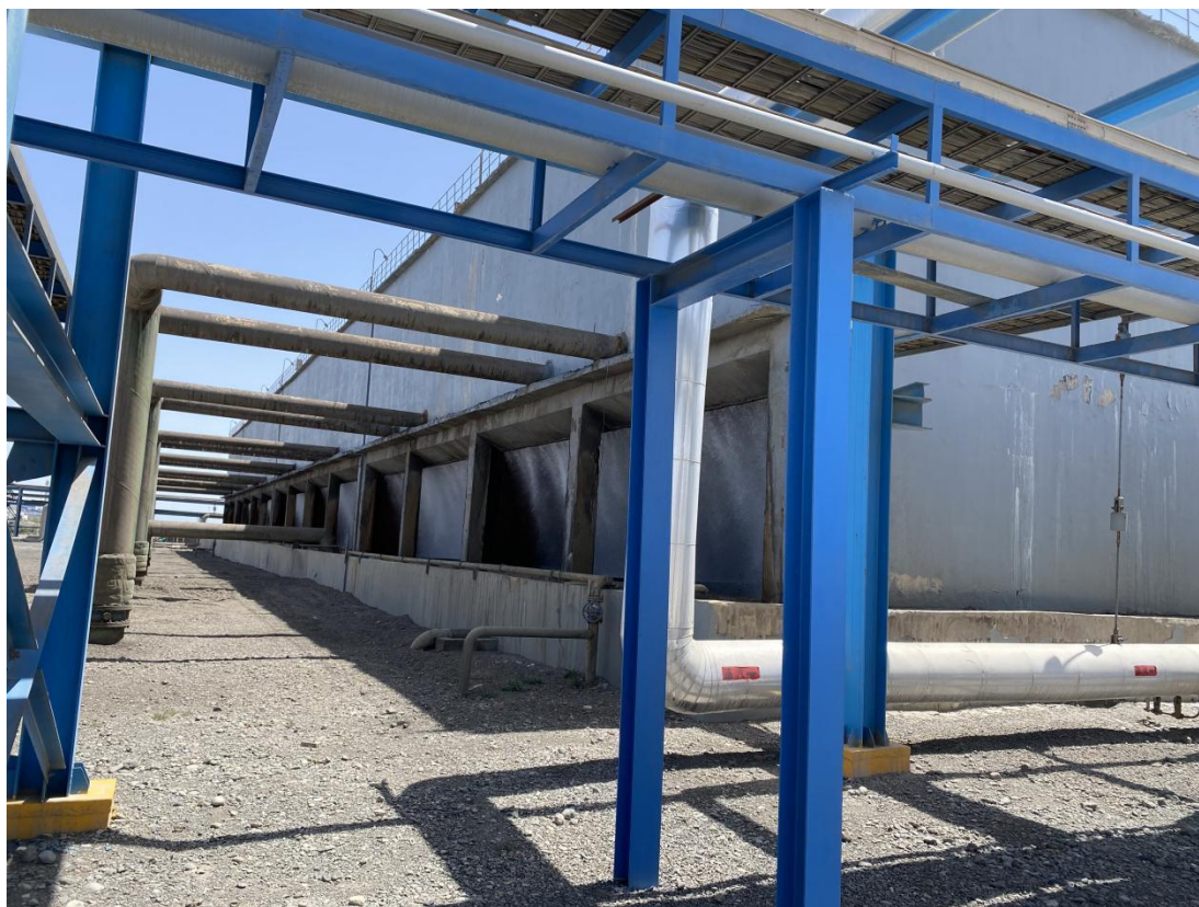
图 2.3-2 循环冷却水系统
