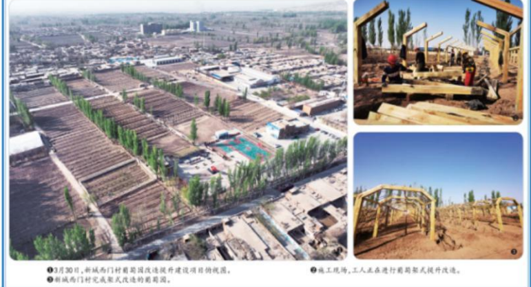
3月30日,新城西门村葡萄园改造提升建设项目航拍。
