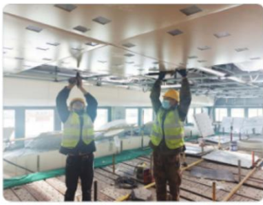
在吐鲁番综合旅游服务中心施工现场,工人在室内完成吊顶施工。
