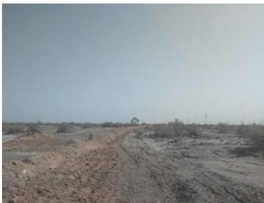
TH12365 管沟恢复
