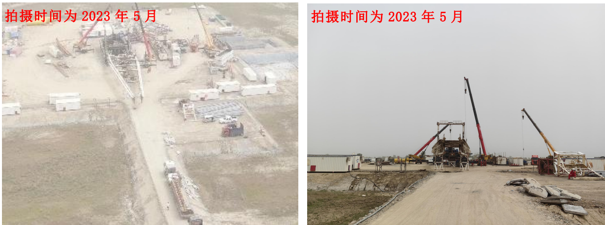
图 3.2-1 井场现状现场照片
