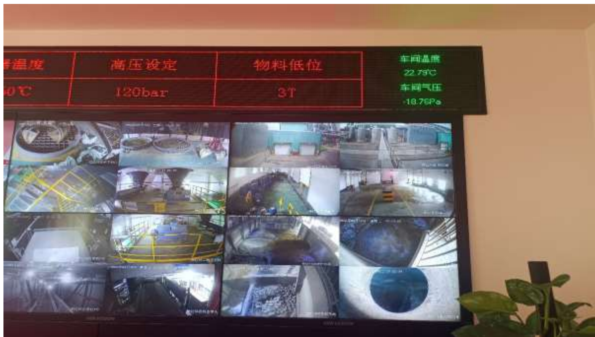
车间温度、气压监控系统照片 (-18.76Pa)
