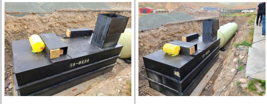
图 2.3-3 地埋式一体化污水处理设备
