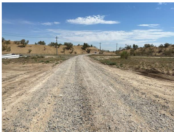
项目区已建道路
