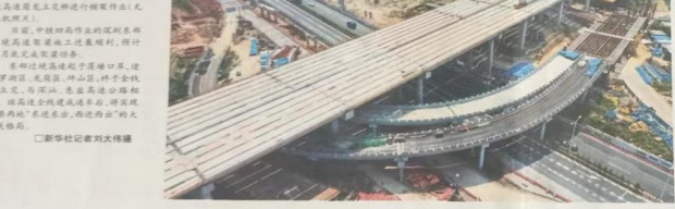
深圳东部过境高架施工进展顺利
