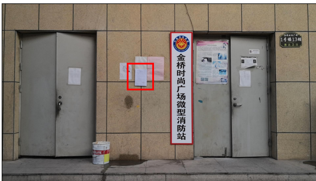
库车金桥时尚广场 1 号楼微型消防站旁张贴公告
