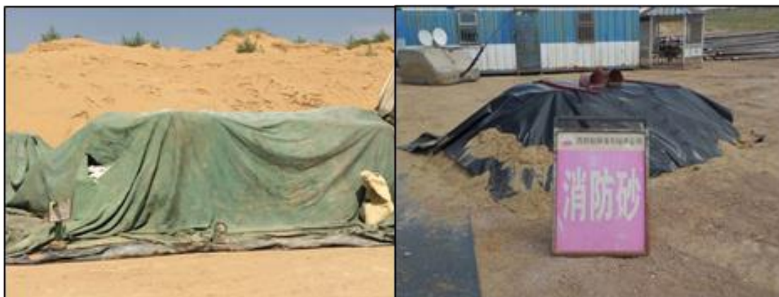
油田常用钻井井场防尘布遮盖示例
