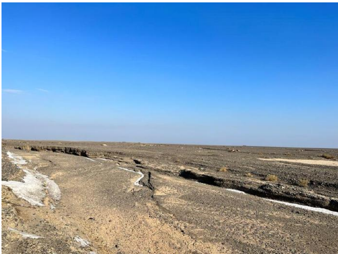
图 4-1-1 线路跨越麻黄沟河
