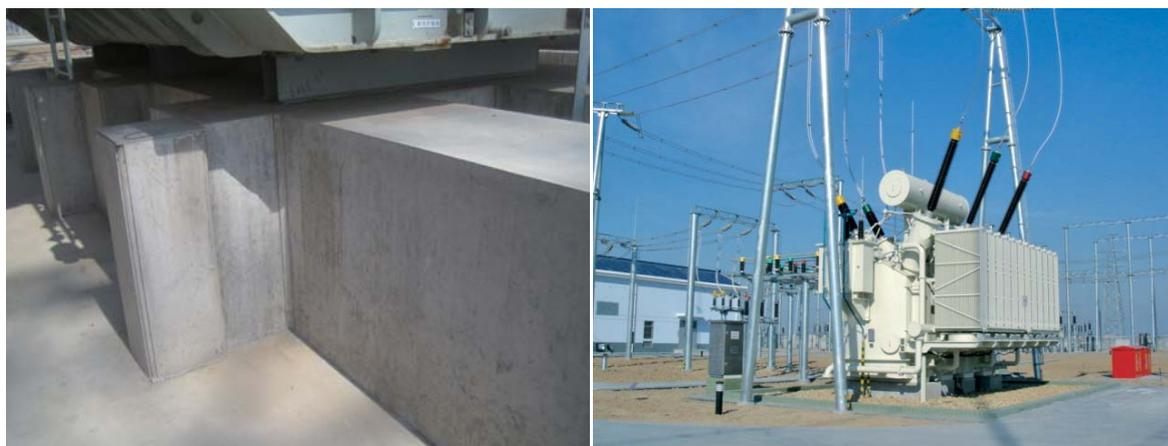
主变储油池示意照（围堰大于设备轮廓 1m）主变基础示意照（储油坑上铺设卵石层）
