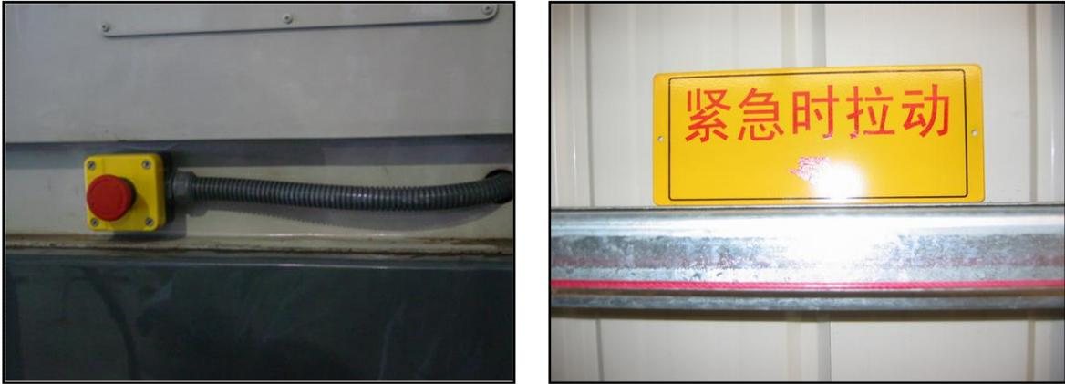
图 10.4-4 急停按钮、急停拉线
