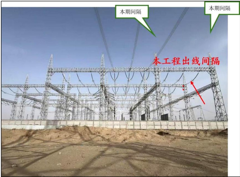
图 3.1-5 且末 750kV 变电站站址现状
