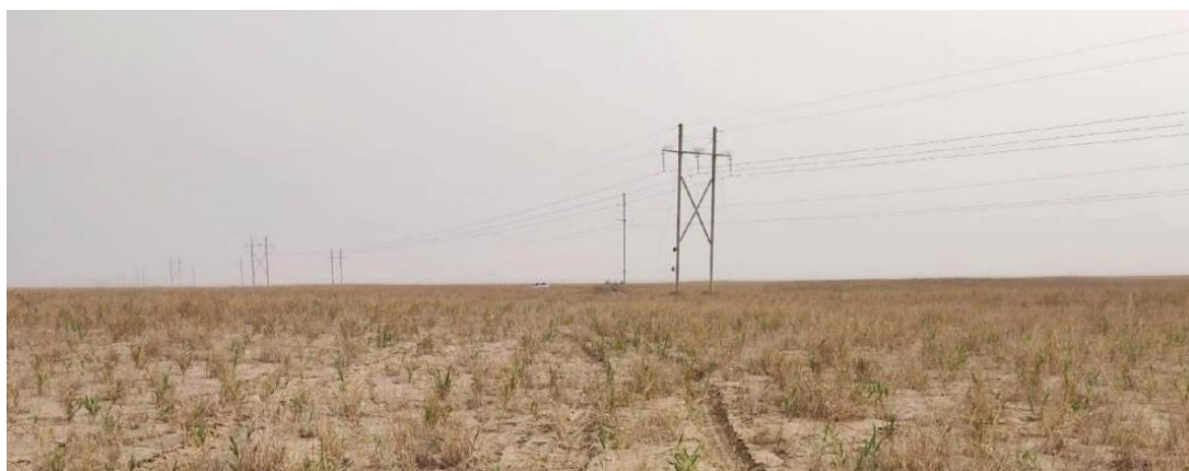
图 3.1-10 跨越 110kV 民安线和 35kV 安柳线
