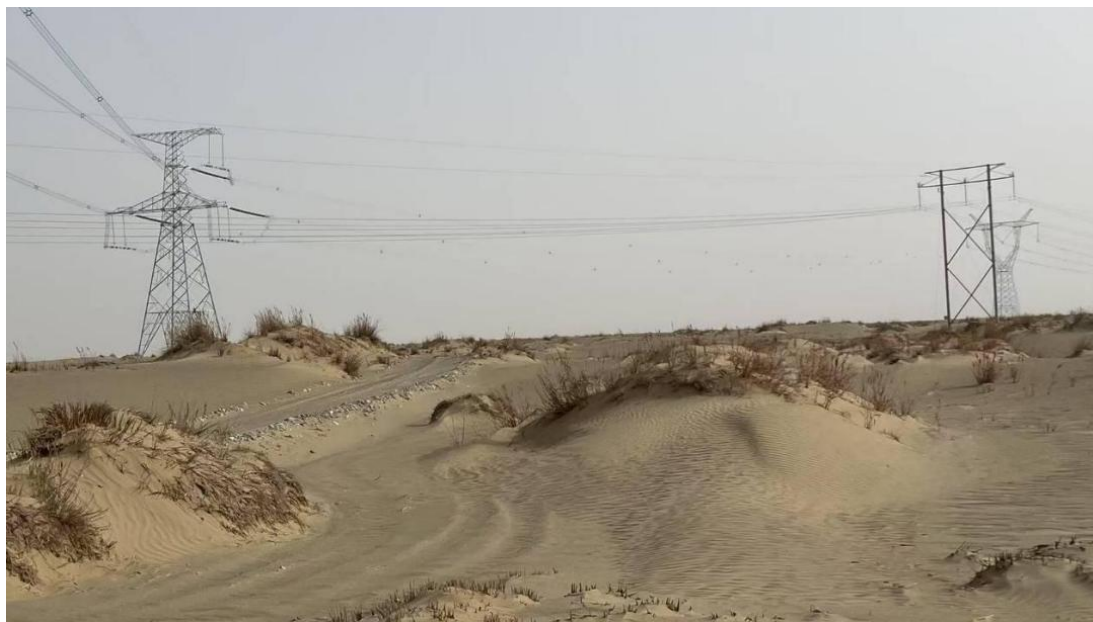
图 3.1-9 跨越 220kV 塔且线
