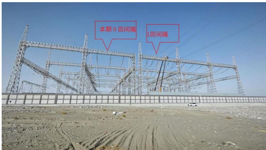
图 3.1-2 民丰 750kV 变电站站址现状
