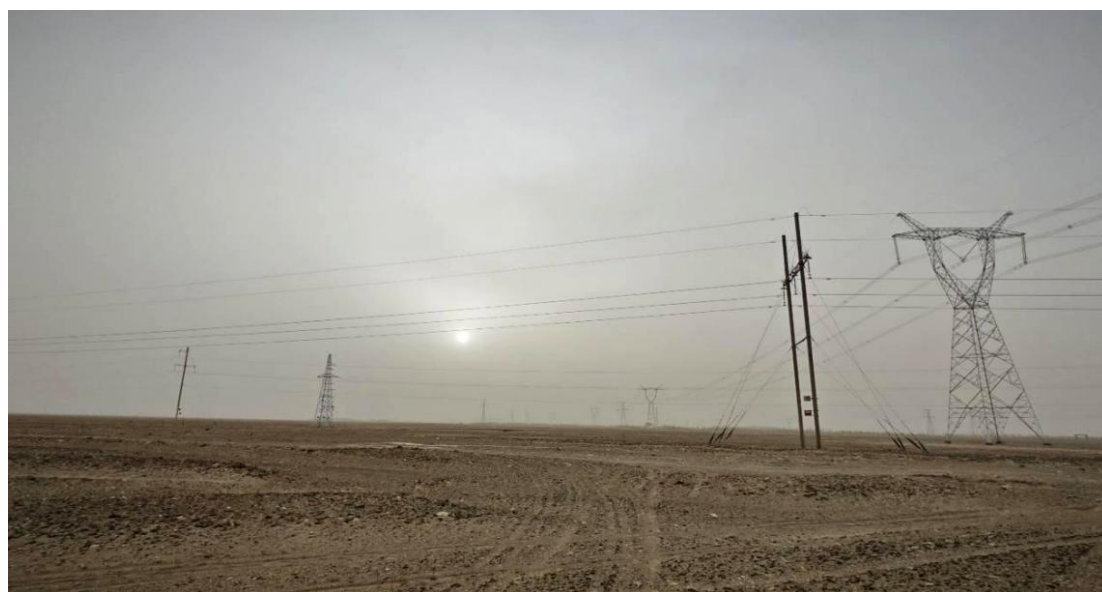
图 3.1-8 跨越和田-民丰 110kV I、II 线和 35kV 线
