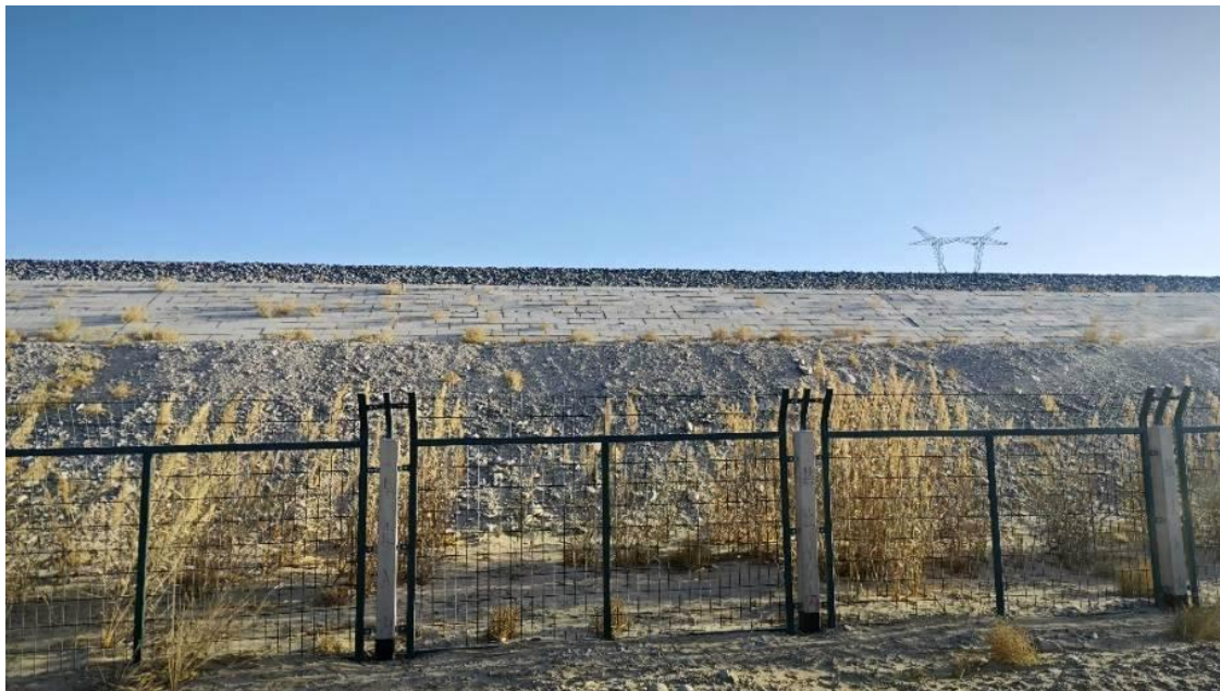
图 3.1-12 跨越和若铁路
