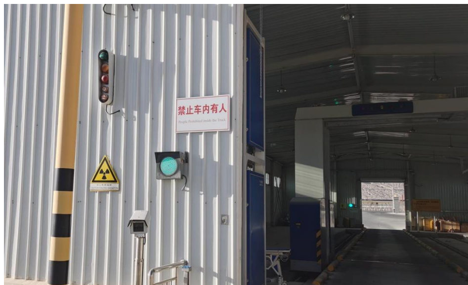
图 10-9 检查系统出束警灯和警铃示意图
