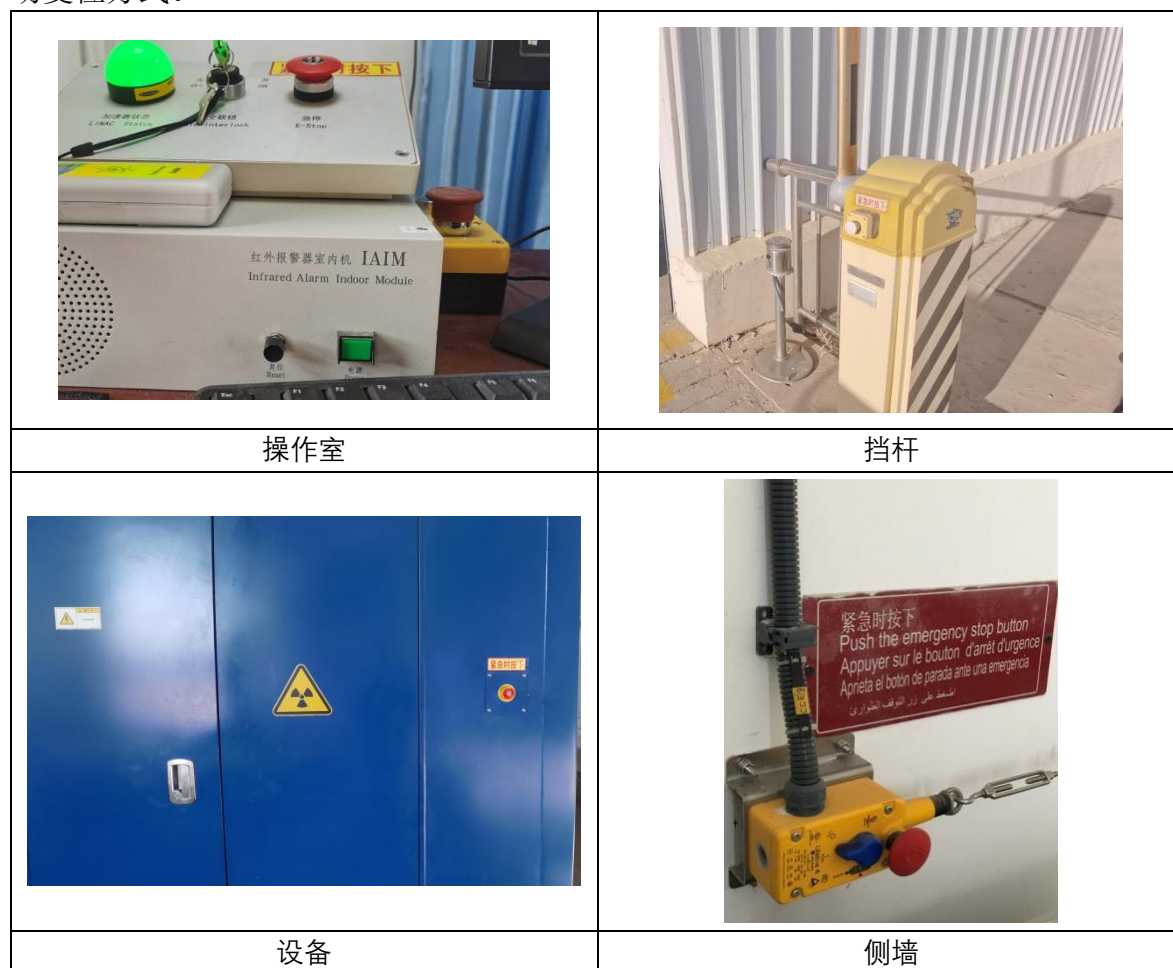
图 10-8 同类型检查系统急停按钮示意图
