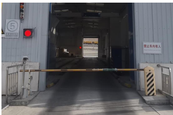
图 10-10 检查系统红外报警装置和挡杆示意图
