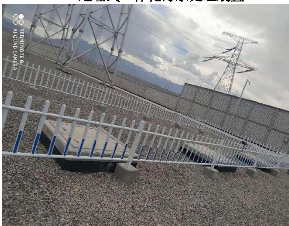
主变事故油池
